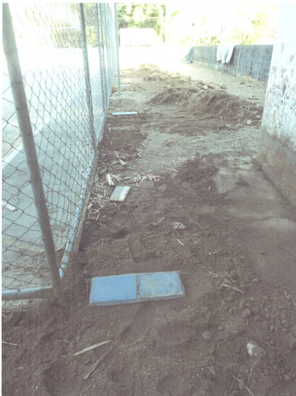
REATERRO DAS SAPATAS
