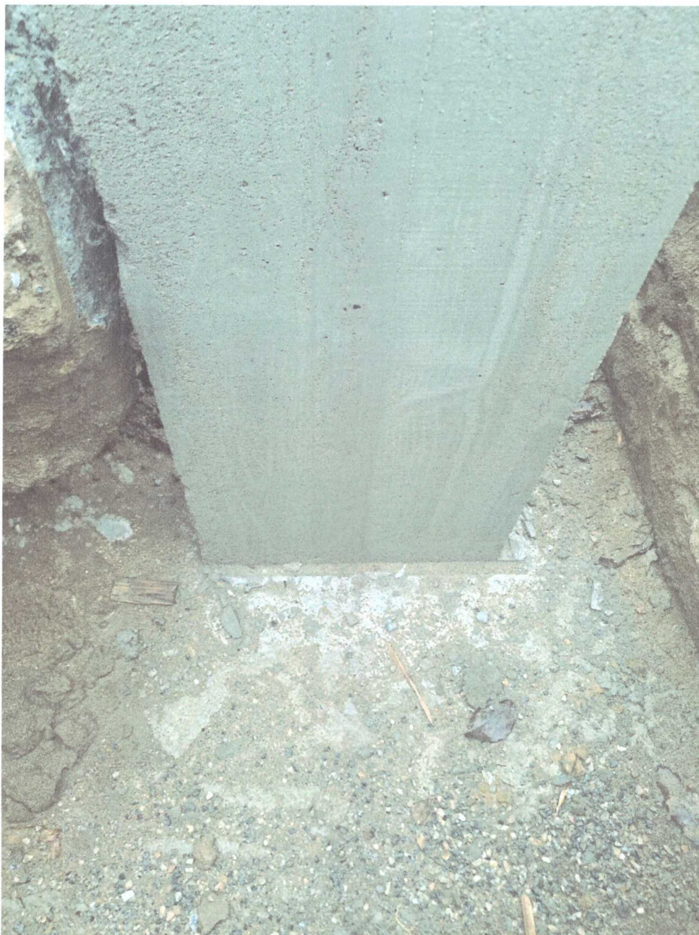
CONCRETAGEM DAS SAPATAS
