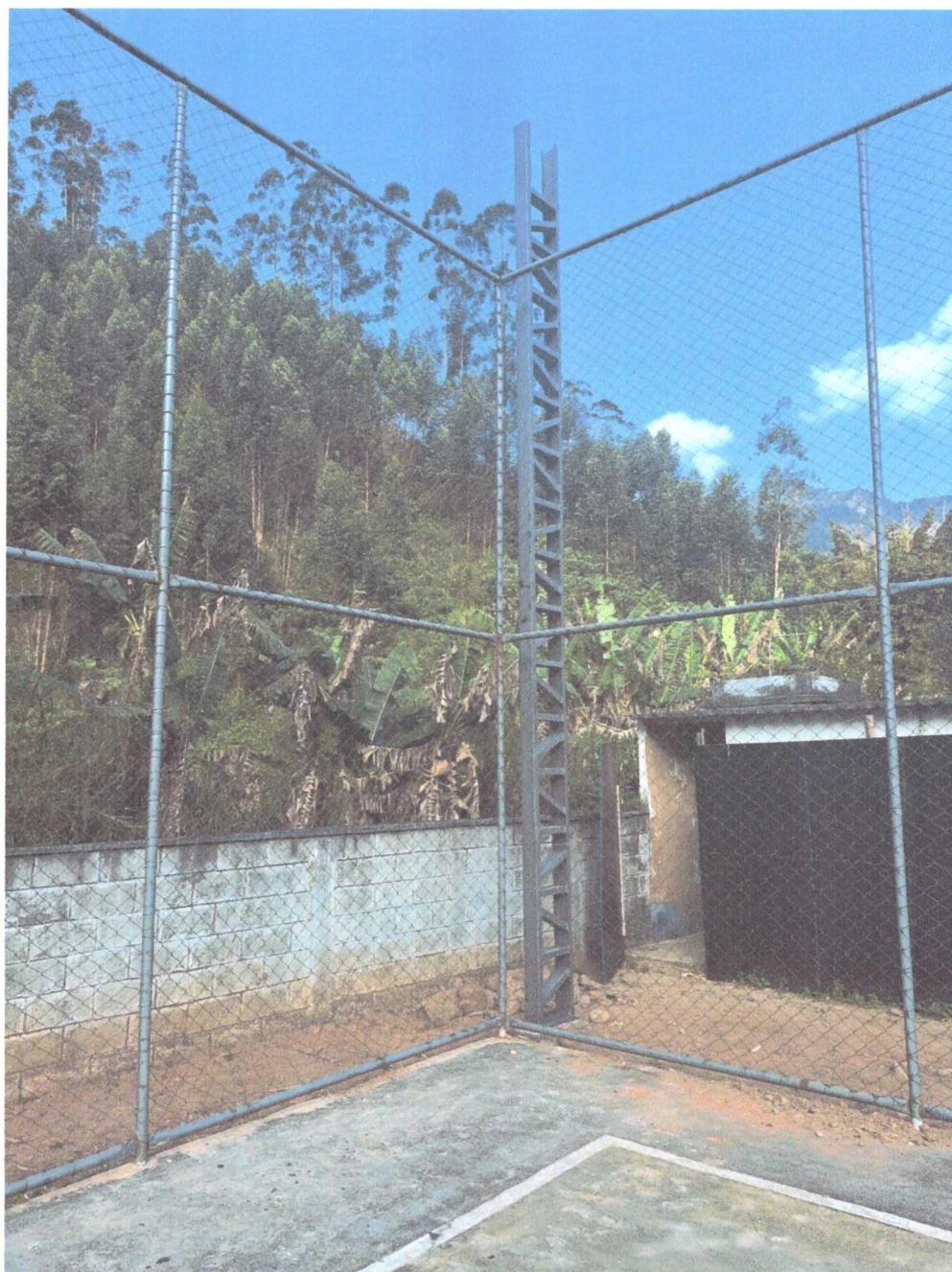
EXECUÇÃO DE ESTRUTURA METALICA
